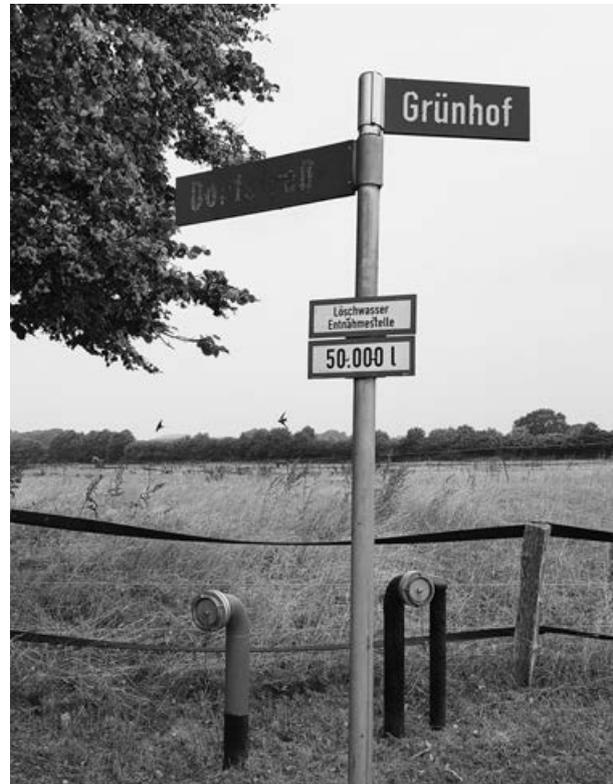
*Unter diesen unscheinbaren Rohren in Böhnhusen befindet sich ein 50.000-l-Löschwasserbehälter.*
