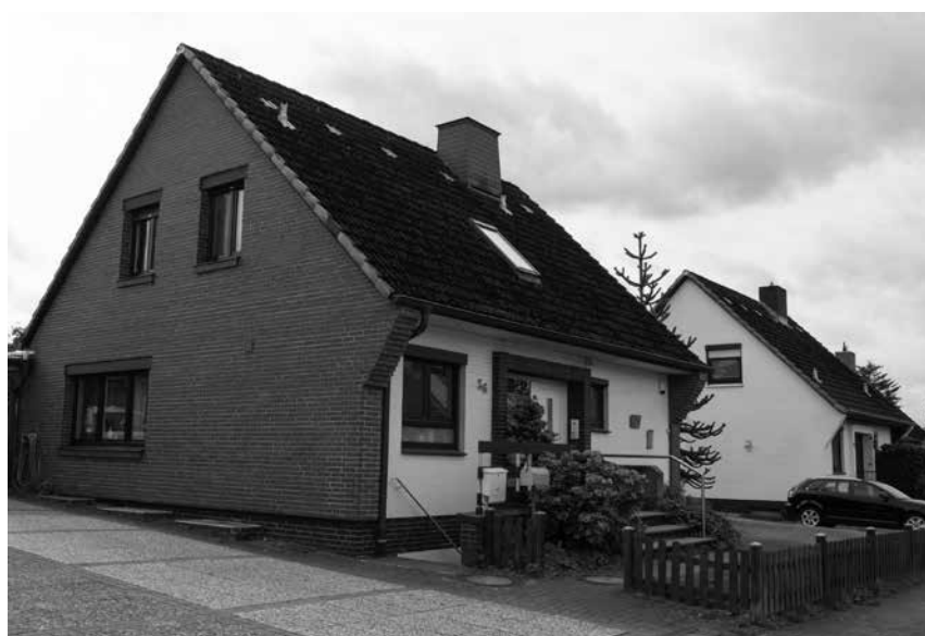
In der Siedlung Sonnenberg wurden von den Siedlern Einfamilienhäuser mit Vollkellern gebaut. In den vorhergehenden Flintbeker Siedlerbund-Gebieten waren es noch Doppelhäuser. Im Laufe der Zeit wurde die nur mit einem Farbanstrich versehene Fassade oft durch eine Klinkerfassade aufgewertet.
