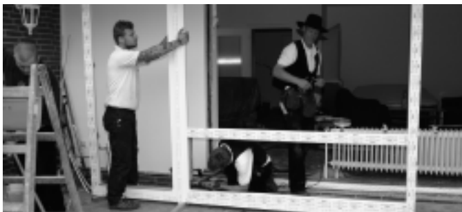
Dieser Fenstertyp eco 8000 MD ratio plus 85B, Innovative Scheibenverklebung, 3-fach Verglasung, Ug-Wert 0,5 mit warmer Kante, Fehlbedienungssperre – fester Mittelsteg i.R, Standard securatio (Sicherheitsbeschlag)
